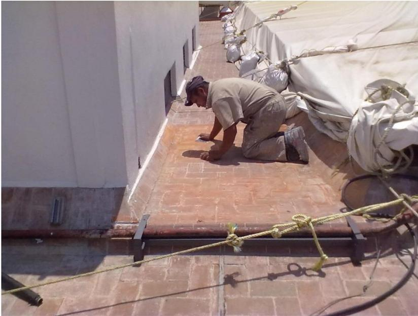
Reparación de oquedades y grietas en losa de ladrillo, retirando falsas adherencias y creando perfil de anclaje para aplicación de recubrimientos posteriores.
